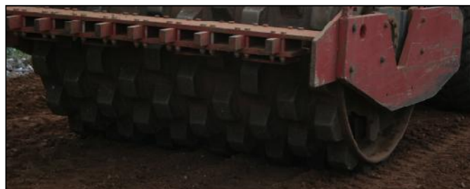
8. Compactar a camada com rolo "pé de carneiro" até atingir 100% da Energia do PI
