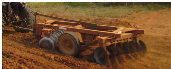
2. Pulverizar o solo até atingir um teor de umidade 2% abaixo da Hot
