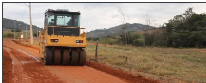
10. Acabamento com rolo de pneus
