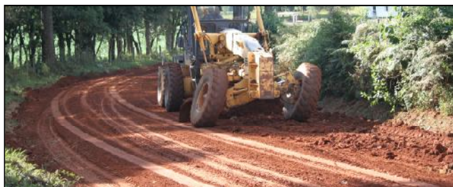
7. Conformar a camada tratada nas dimensões projetadas
