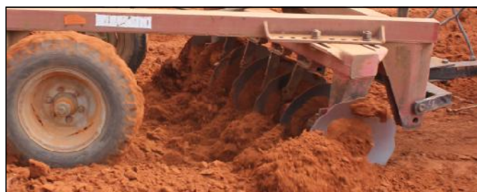
6. Homogeneizar o solo + BS-Plus + Sulfato de Alumínio
