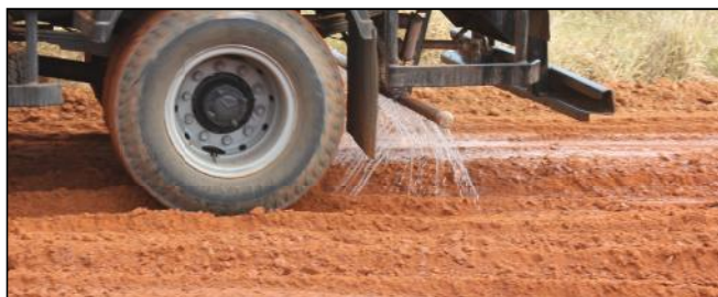
3. Distribuir o BS-Plus + 50% da água necessária para atingir a Hot
