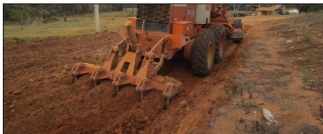
1. Escarificar o solo com o garfo da motoniveladora na espessura de projeto
