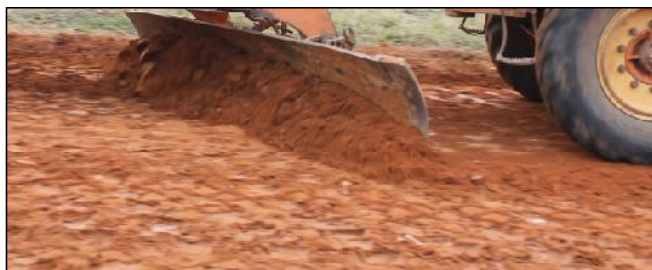
9. Operação de Corte Mínimo
