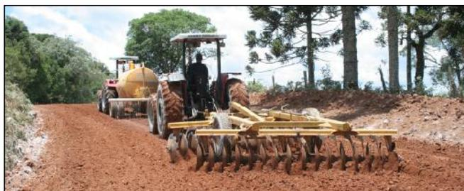
9. Pulverizar todo o material até formar uma mistura uniforme e homogênea, pelo tempo que for necessário.
