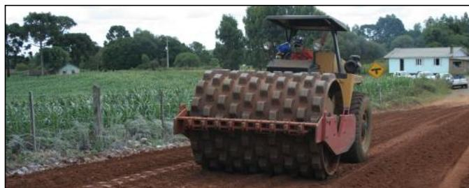
10. Compactar a camada com o rolo específico para o tipo de solo e espessura da camada.
